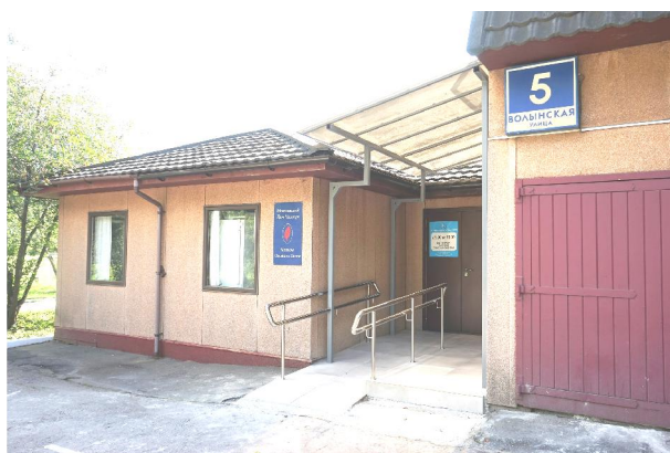
Фото 9.1. Внешний вид обновленного пандуса № 1 на входе в протезную мастерскую (северная сторона здания Организации).
